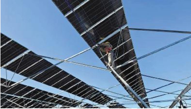
黑龙江肇源“渔光一体”电站运维团队紧固螺栓
