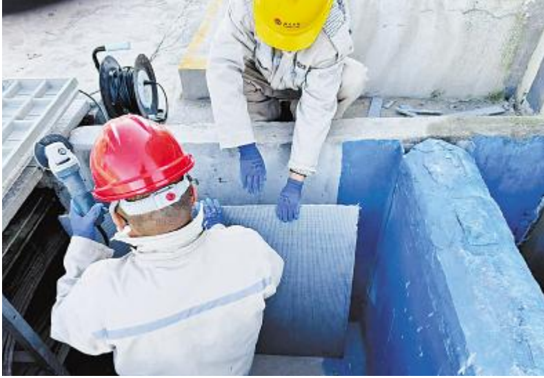
黑龙江肇源“渔光一体”电站运维团队为电缆沟增设防火墙
